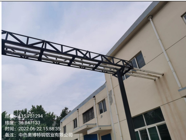
废水输送管道（架空、分质）
