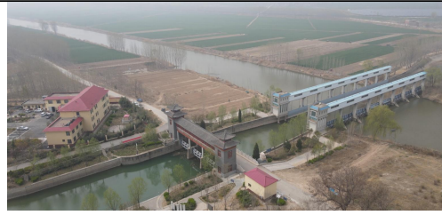
冠县三千渠入口闸
