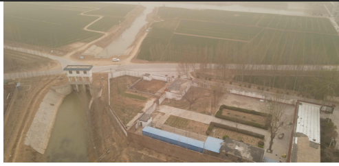
王浩沟入口闸
